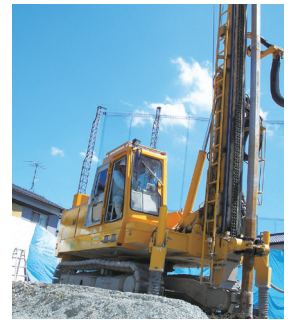
地盤改良工事の施工風景。
