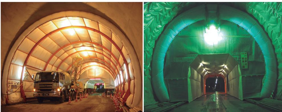
「トンネルバルーン」での養生で高品質なコンクリートが得られる。写真は、覆工コンクリート表面を覆って保温・湿潤養生する「コンクリート用バルーン」(左)、型枠全体を物理的に覆って保温養生する「セメント用バルーン」(右)。
