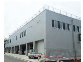
2012年になって車庫棟の上に増築された大会議室(上階部分)。災害時は危機管理棟としての役割を果たす。
